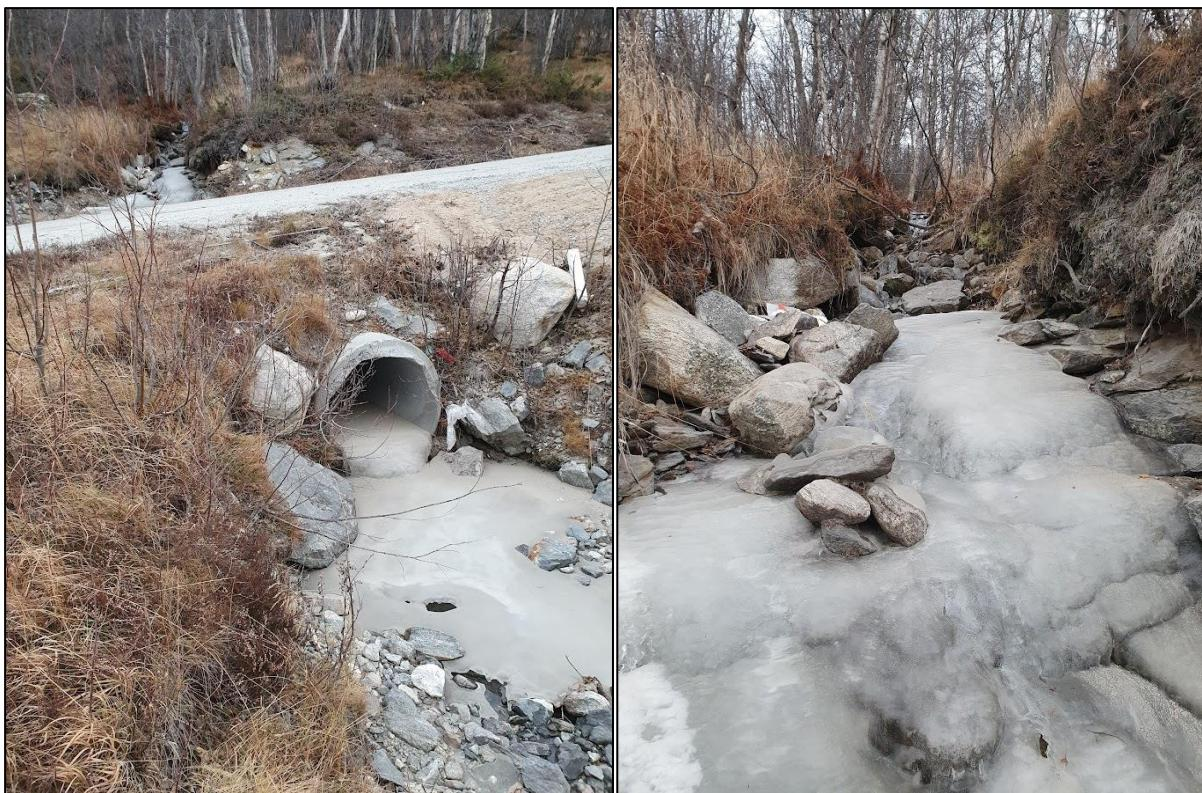
Figur 11: Høgre bilet: Bekk 3a nedstraums for planområdet der den kryssar Liarbergvegen i eitt betongrør med ein innvending diameter på 600 mm. Bekk 3b ved inntaket til kulverten under vegen.
