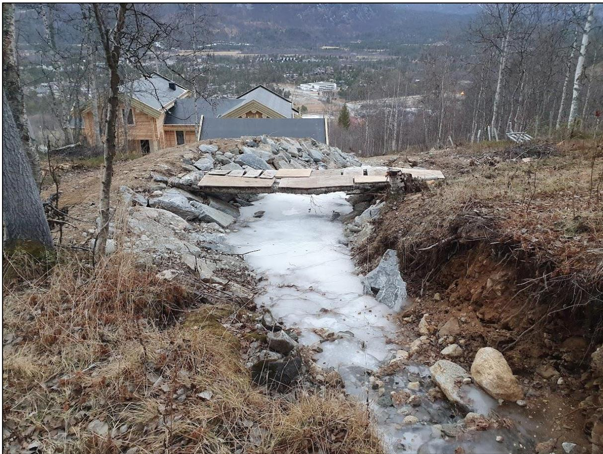
Figur 6: Erosjonssikra bekkeløp til Gorrobrennbekken langs vestre avgrensing av planområdet gjev tilstrekkeleg tryggleik mot flaum og erosjon i BFF1.
