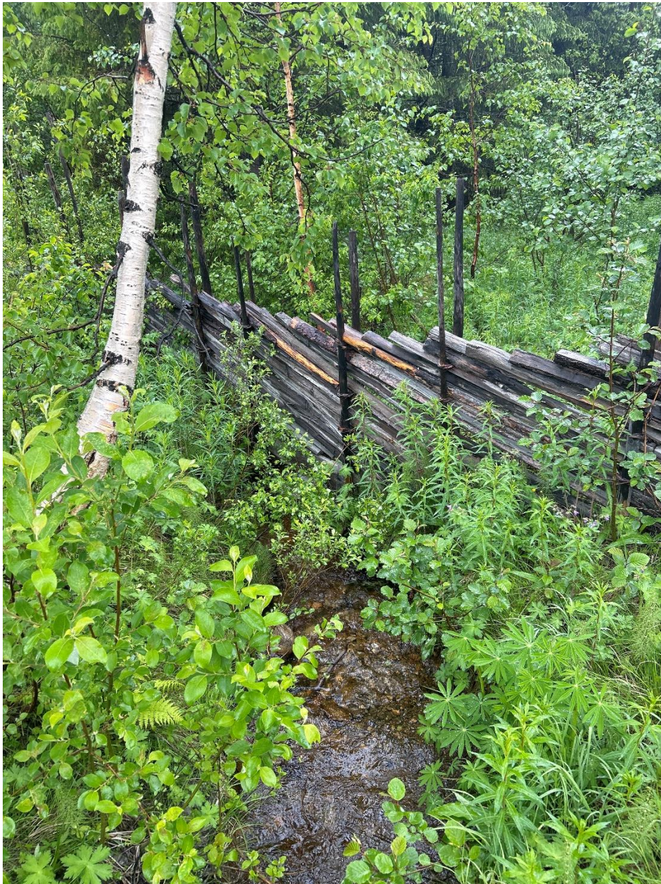
Figur 49: Gjerde over bekken kan føre til gjentetting og vann på avveie mot bebyggelse ved punkt 97
