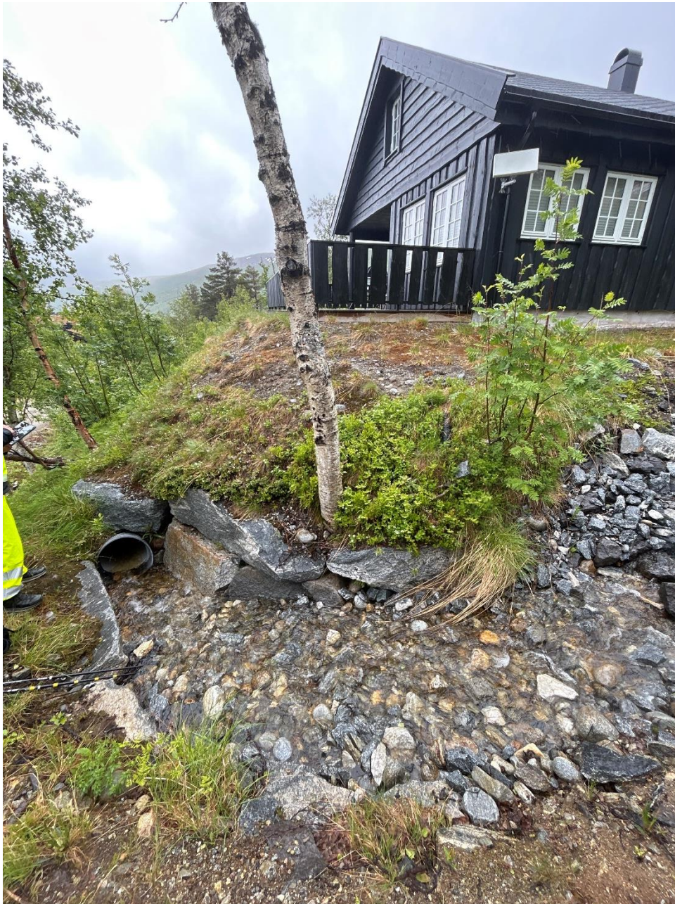
Figur 55: Bekk lagt om rundt hytte ved punkt 125. Sårbart.
