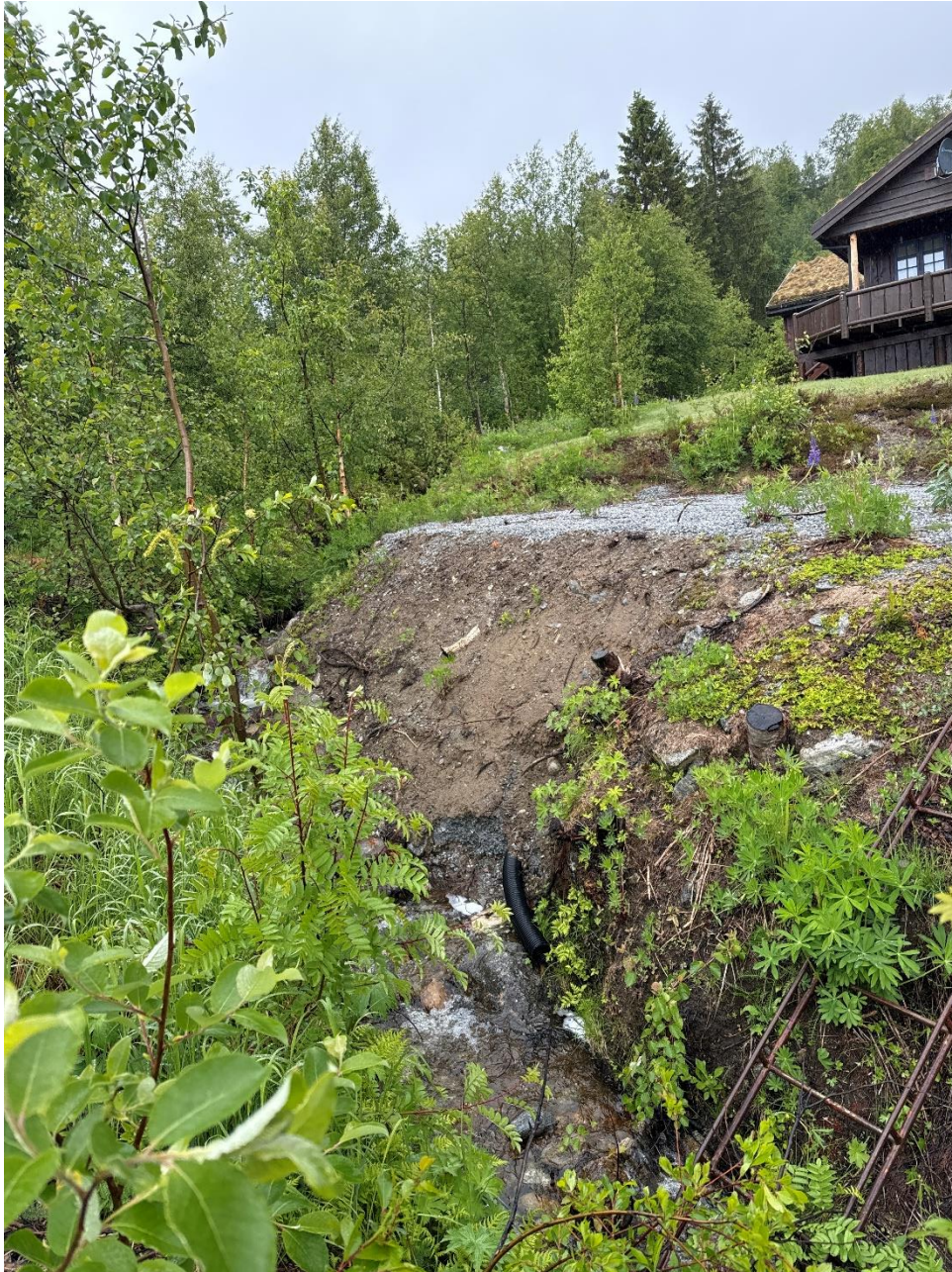
Figur 50: Fylling lagt ut i bekkeløpet ved punkt 110, og drensør fra fyllinga rett ut i bekken.
