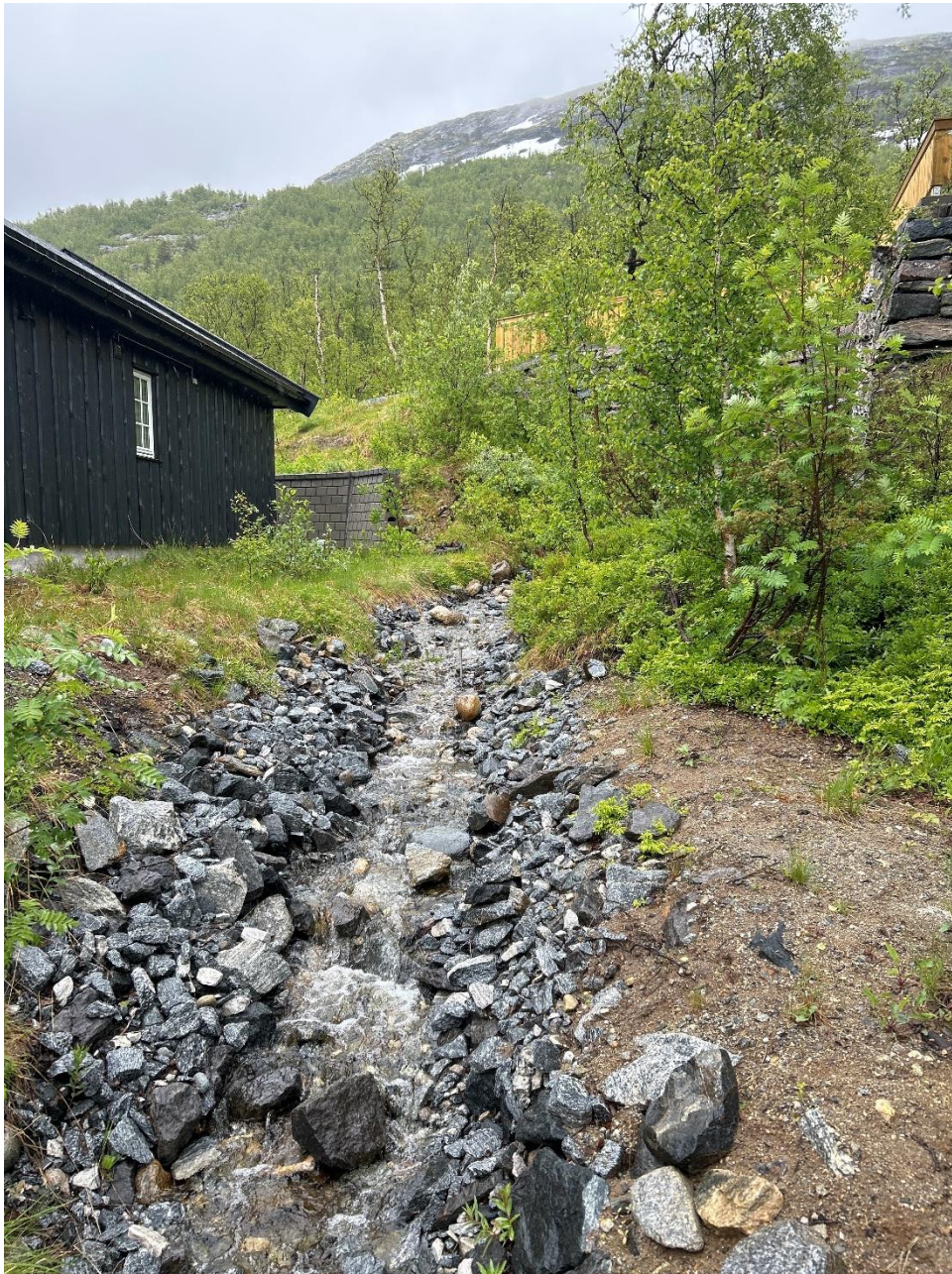
Figur 54: Bekk lagt om rundt hytte ved punkt 125. Svært dårlig erosjonssikring.
