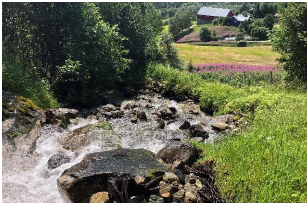
Figur 14: Flomvoll mot jordet ved punkt 510. Bekken er svært masseførende, og vollen er derfor sårbar for overtopping. (Norconsult AS, 2021)
