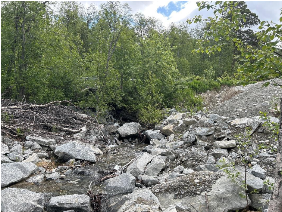
Figur 45: Fylling ved punkt 58.
