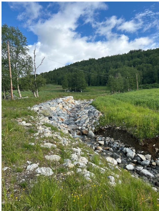
Figur 21: Omlagt og sikret bekkeløp ved punkt 44.
