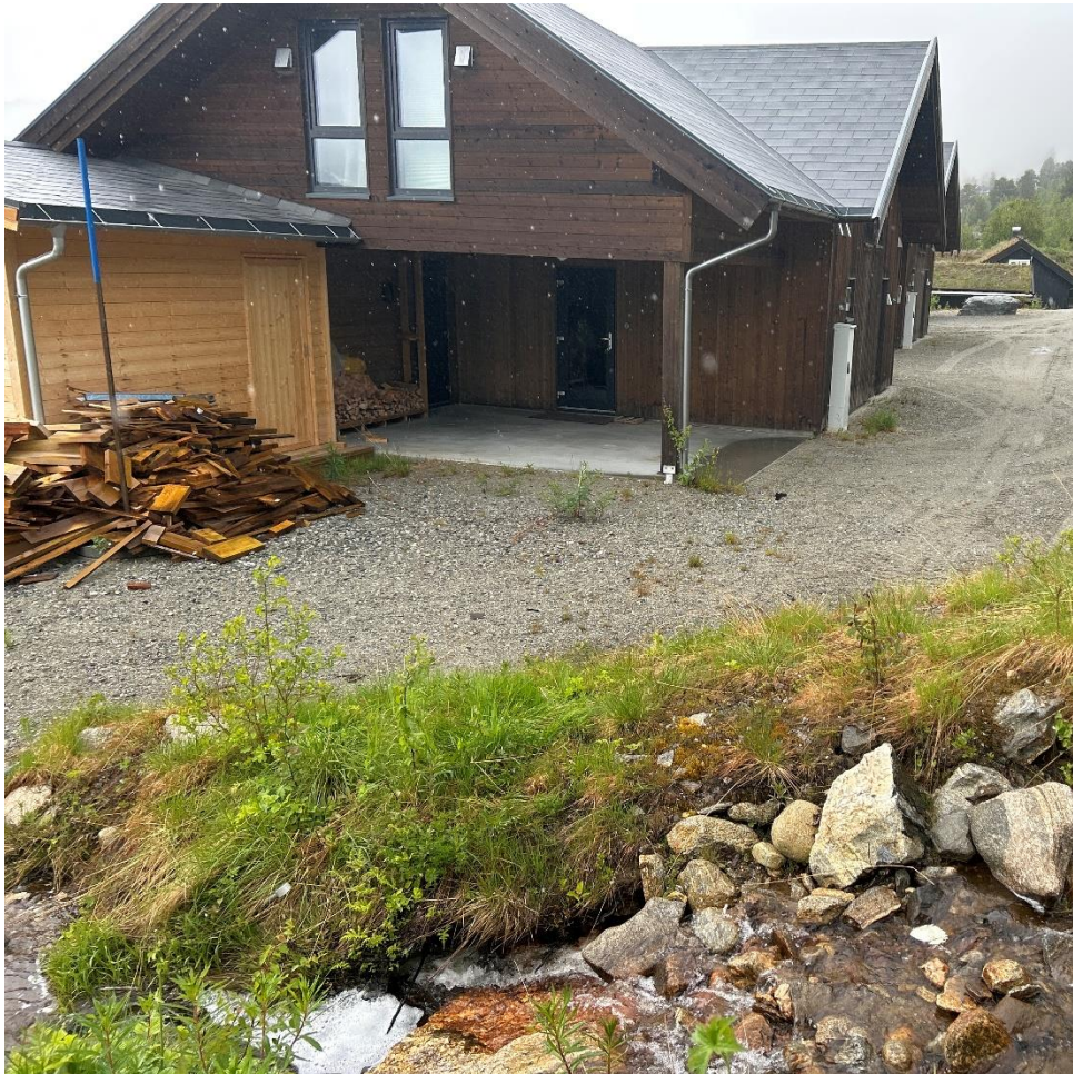
Figur 51: Bekk lagt om i forbindelse med utbygging. Bebyggelse tett på bekkeløpet ved punkt 115
