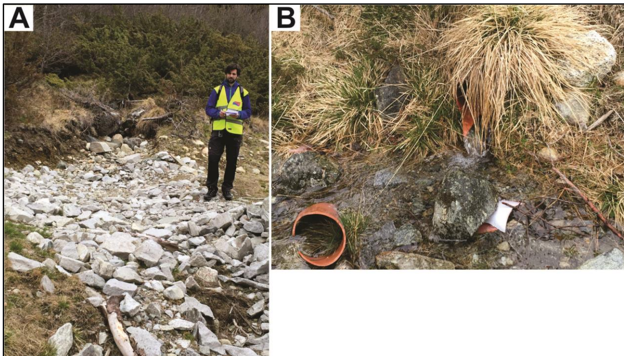
Figur 26: A: Eit bekkefaret er lagt over skogsvegen om lag 60 m nord for planområdet. Det er laga til ei grunn forseinking plastra med stein. B: Frå nordvest kjem det eit røyrt med vassføring i. Det er ikkje kjend kvar dette røyret kjem frå.
