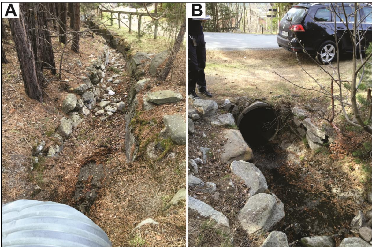
Figur 22: A: Nedanfor Honnavegen er bekkefaret plastra med naturstein. God plastring i botn av bekkefaret hindrar undergraving av muren. B: Det er sett opp ein natursteinsmur inn mot inntaket til gjennomføringa under Honnavegen også her botn på inntaket solid, noko som hindrar undergraving.
