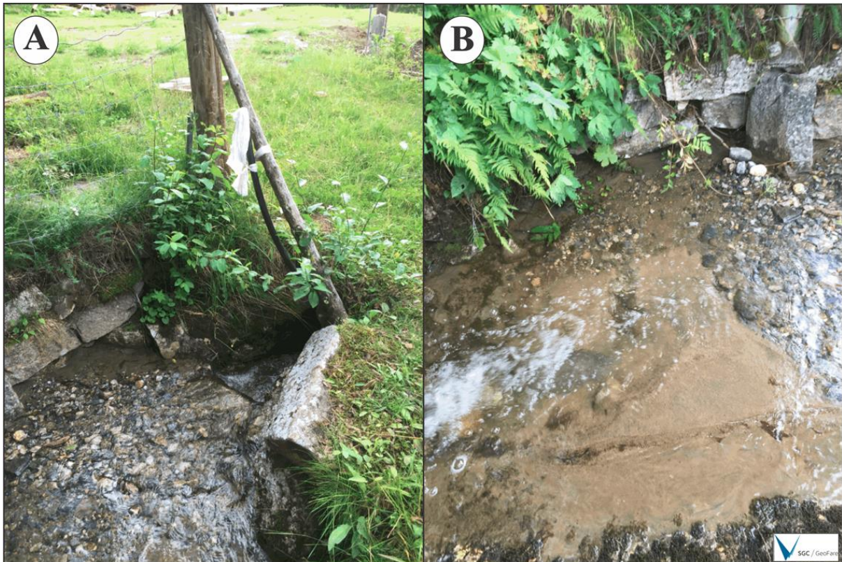
Figur 16: Bilda viser gjennomføringa under skogsvegen (bilde A), og dammen som har danna seg over tid i tilknytning til kulverten (bilde B). Under vegen er det eit problem med danning av ispluggar om vinteren. Lokasjonen ligg om lag rett vest for hytta med bruksnr. 34.
