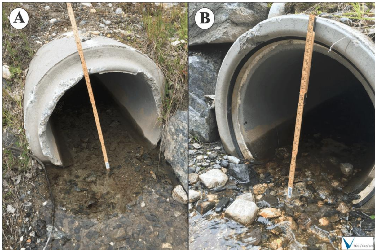
Figur 27: Bilda viser eksempel på korleis lausmassar vert avsett i eksisterande rør. Det er viktig at gjennomføringar vert renska med jamne mellomrom. Denne gjennomføringa har ein diameter på 60 cm. ( \Phi=60 cm).
