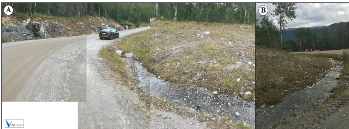
Figur 20: Bilde viser Bekk-2, der den kjem ned mot tilkomstvegen ved hårnålsvingen. Den renn vidare under vegen i eit betongrøyv (Φ=60 cm), og følger grøfta på oppsida av vegen og ned mot Bekk-3, der bekkane renn saman.
