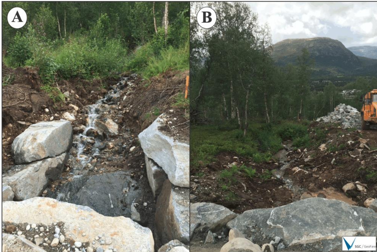
Figur 15: Bilda viser korleis bekken er forma inn mot gjennomføringa. Bilde A) er tatt mot nord, medan bilde B) er tatt mot sør. Bekken bør steinsettast langs sidene.
