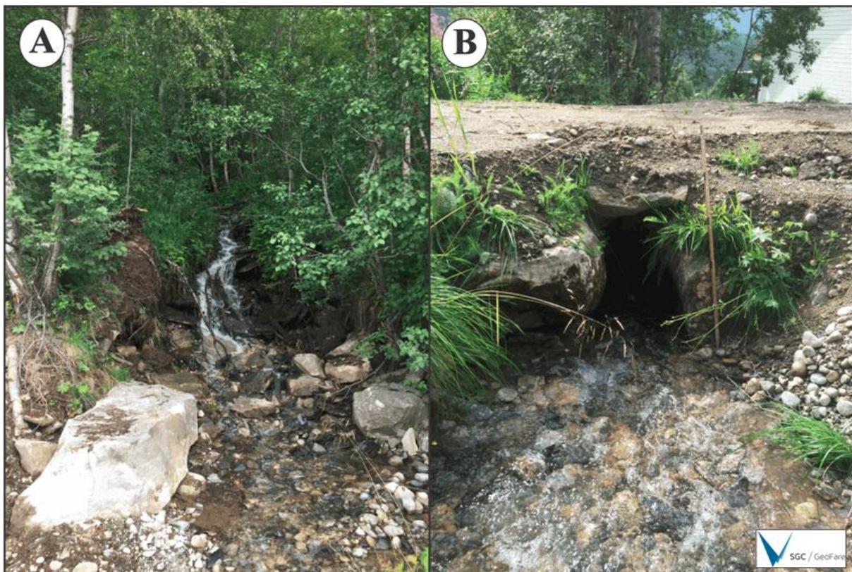
Figur 24: Bilde viser nedre delar av Bekk-3 heilt sørvest i planområdet, nær Bjorli låve. Her renn bekkene inn i kulverten under tilkomstvegen til hytta på bruksnr. 34 (sjå Figur 19). Her renn òg sidebekken som delar seg omlag 25 m lenger opp i lia (Sjå Figur 25), inn i kulverten og følger bekkene vidare mot sørvest. Gjennomføringa er steinsatt, med ein dimensjon på 80x40 cm.
