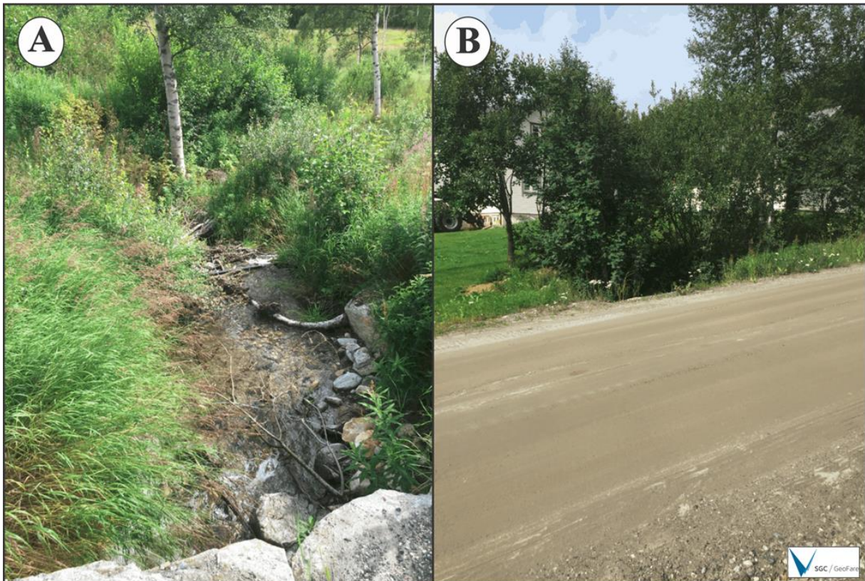
Figur 26: Bilda viser nederste delen av Bekk-3 i området der denne er undersøkt. Bekken renn under tilkomstvegen inn i området gjennom eit betongrøyr ( \Phi=80 cm). Vi observerer at elveløpet inneheld relativt mykje greiner og små trer som ligg sjølve bekkefaret. Desse kan vere ein risiko med omsyn til å demme opp bekken i periodar med høg vassføring. Det er viktig at alle bekkefara vert reinska opp.
