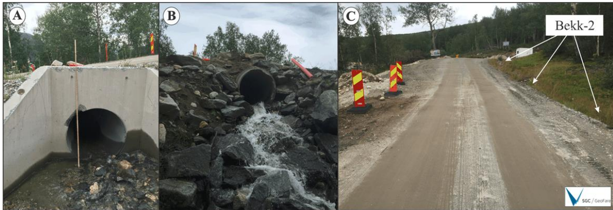
Figur 21: Bilda er av kulverten der dei tre bekkfara møtes og renn vidare på nedsida (vest) av vegen. Bilde A) viser kulverten på oppsida av vegen, med ei gjennomføring, eit betongrøyr med diameter på 1,0 m. Bilde B) viser betongrøret/gjennomføringa på nedsida av vegen. Bilde C) viser grøfta der Bekk-2 renn sørover mot Bekk-3. (J.fr. Figur 19).
