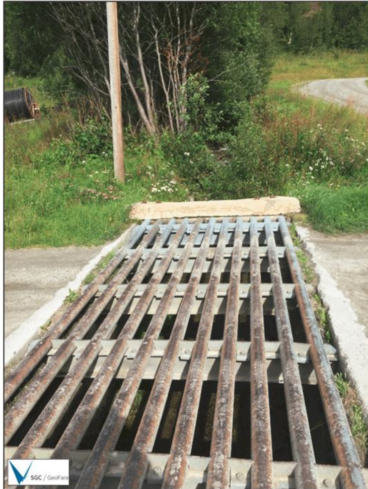
Figur 18: Bildet viser nedre del av Bekk-1 der den kryssar vegen under ei ferist som ligg som ei bru over vegen. Her er gjennomføringa både sider og botn, støypt i betong. Dette hindrar erosjon i periodar med stor vassføring.
