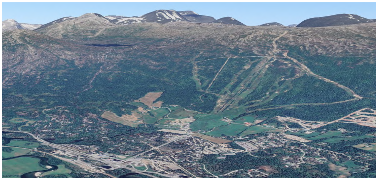
Figur 12. Bildet viser Bjorli med eksisterende skitrekk og sentralområde ved bunn av skiheisen. Til venstre ligger Bjorlitoppen hvor nye nedfartsløyper planlegges. Kilde: GoogleMaps
