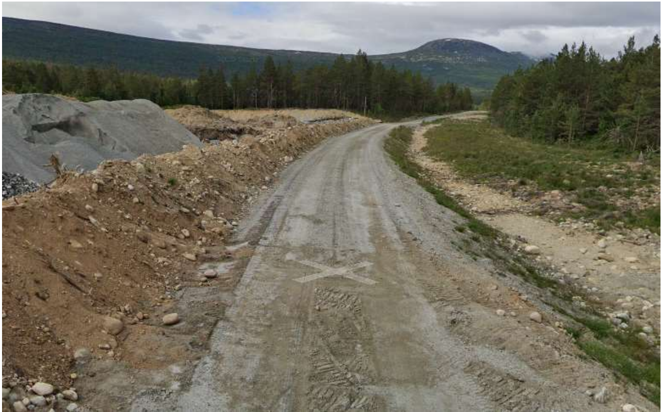
Figur 12. Skjermingsvoll sør for Brekkelivegen langs uttaksgrensen sett mot vest. Kilde: Google Street View.
