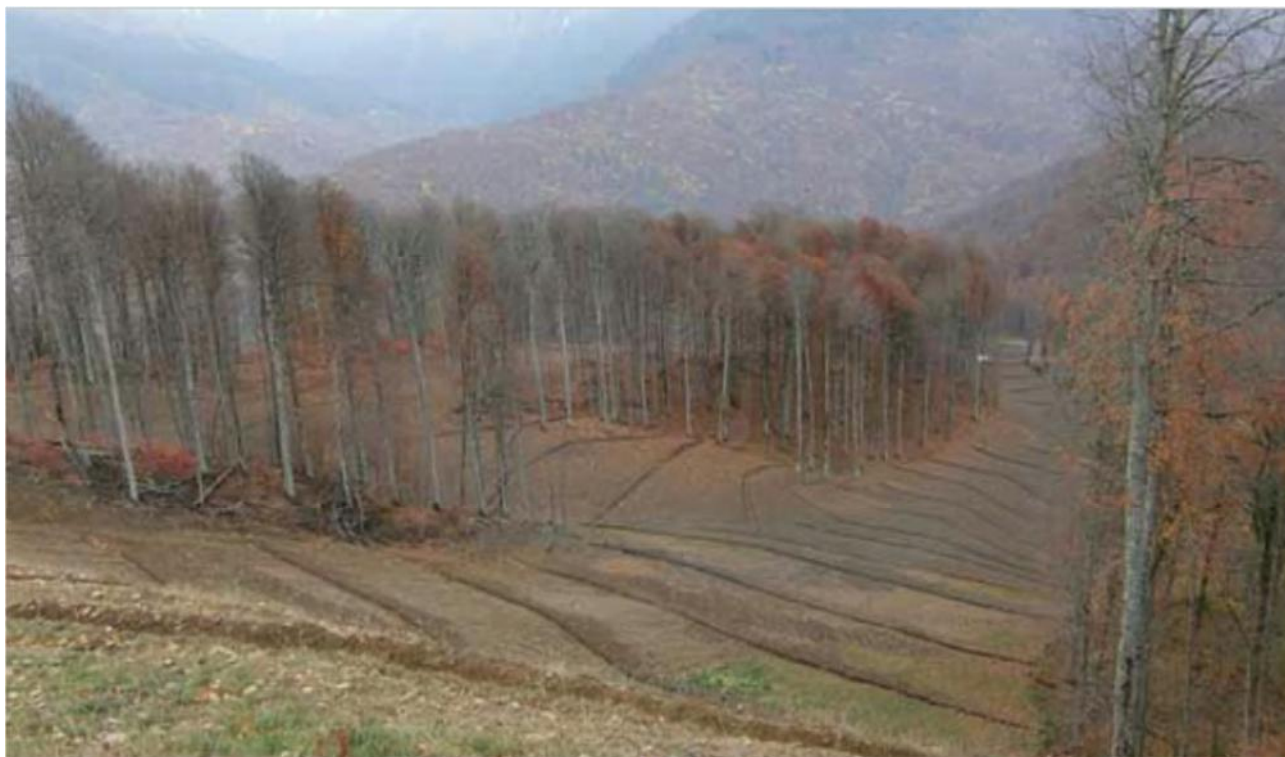
Figur 30: Eksempel på god drening av nedfartsløype og drenering av vann ut i terrenget. Hentet fra Kulturdepartementets veileder for alpinanlegg.
