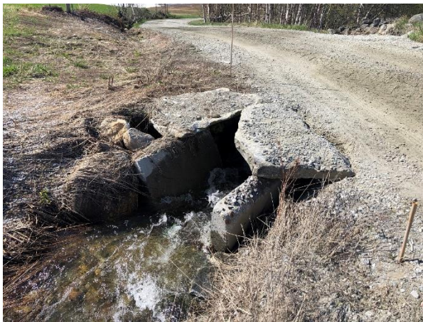
Figur 12: Bildene viser situasjonen i Pinsen 2020, dagen før flommen. Oppe til venstre ser en bekken fra stikkrenne gjennom gardsveg/Bjorlivegen og nedstrøm (rett øst for skianlegget). Til høyre viser strekningen før veikrysning via stikkrenne i bratt terreng, sett nedenifra. Nede til venstre sees stikkrenneinnløpet, mens bildet til høyre er tatt fra vegen nedover mot utløp, der en ser utvasking av vegen over stikkrenna.
