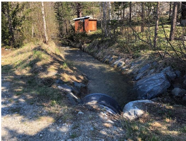
Figur 14: Bildene viser situasjonen i Pinsen 2020, dagen før flommen. Øverst sees inntakene under Bjorlivegen før de går sammen på jorden nedstrøms. De to nederste bildene viser inn (til venstre) og utløp (til høyre) gjennom grusveg nordvest for Veslegrenda rett før samløp med bekk B4.
