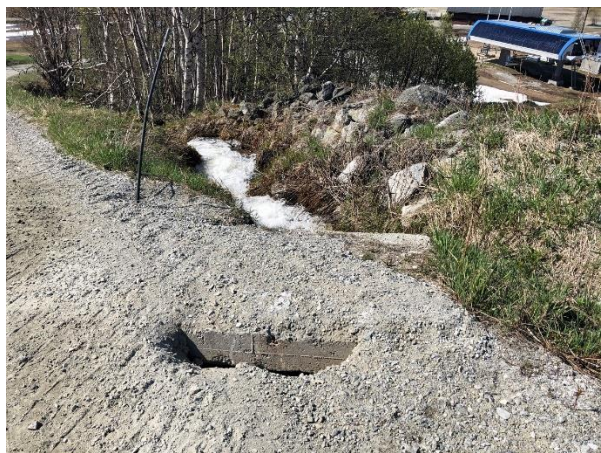
Figur 12: Bildene viser situasjonen i Pinsen 2020, dagen før flommen. Oppe til venstre ser en bekken fra stikkrenne gjennom gardsveg/Bjorlivegen og nedstrøm (rett øst for skianlegget). Til høyre viser strekningen før veikrysning via stikkrenne i bratt terreng, sett nedenifra. Nede til venstre sees stikkrenneinnløpet, mens bildet til høyre er tatt fra vegen nedover mot utløp, der en ser utvasking av vegen over stikkrenna.
