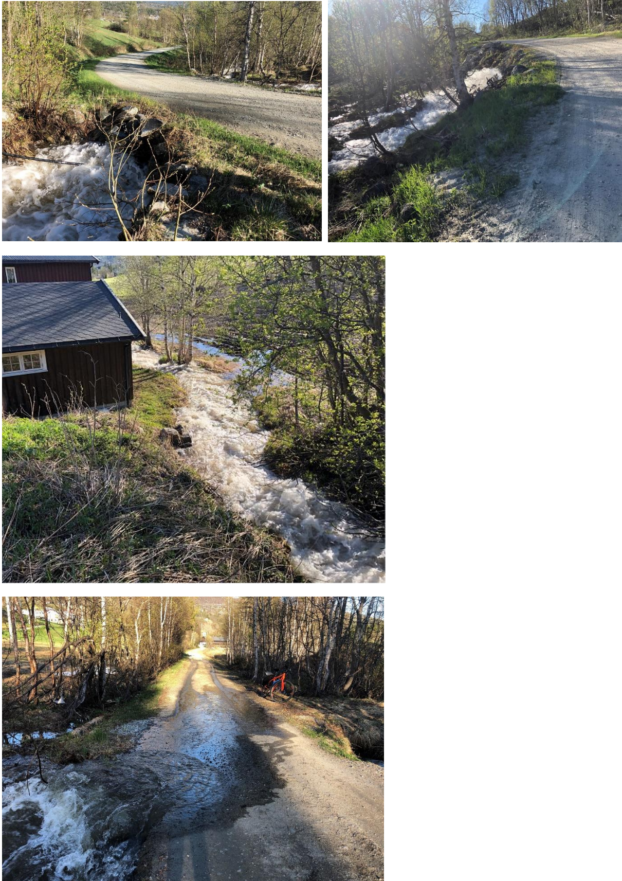
Figur 8: Bildene viser flomsituasjonen i Pinsen 2020. De to øverste er fra veikrysningen ved Bjorlihaugen hvor flomvannet stod og kokte mot stikkrenna, som var helt dykket. Midtre bilde er fra Bjordal lengre nedstrøms. Nederst sees flomvannet i ferd med renne over og vaske ut gardsvegen på flata nedenfor Bjorlivollen.
