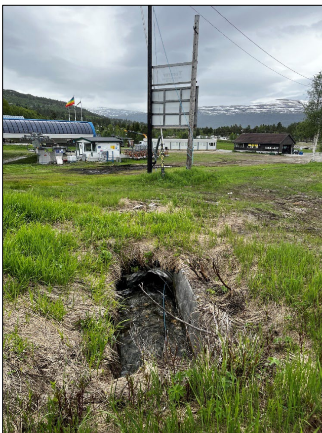
Figur 2: Dagens rørledning under bunnområdet. (Sturla Sæle, Areal+ AS)
